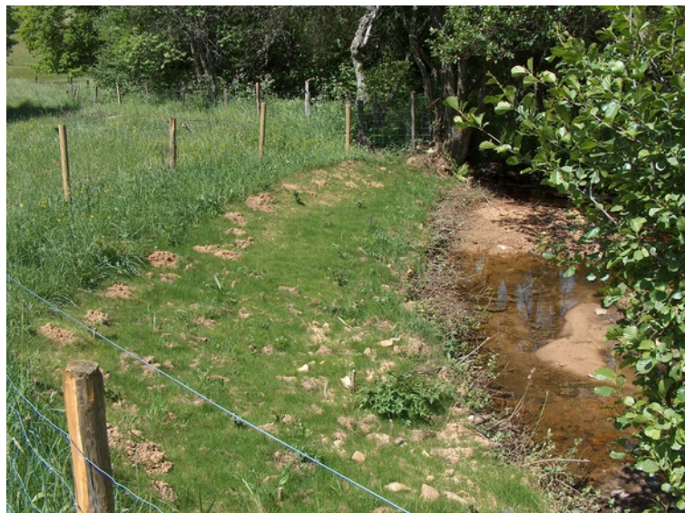
Chantier école pour les techniques de génie végétal (Cantal)
